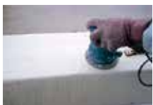
施工面をサンダーで荒す
