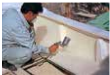
エアガン施工
