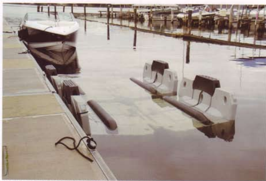
下架状態のVリフト。機橋への固定は上下架の差異でロープ調整を行う必要がある。
