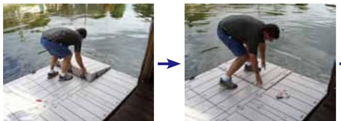
コネクタドックの接続は非常に簡単で、数本のボルトを使用し数分で完成してしまいます。使用する工具はソケットレンチ(16mm)のみ。誰でも迷うことなく簡単に接続できます。
