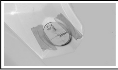
所定の位置にある穴テンプレート-GTX-RXTモデルを表示
