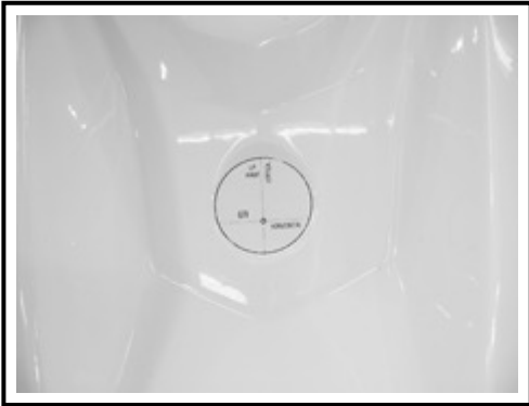
所定の位置にある穴テンプレート-GTI、GTR、およびGTSモデルを表示
